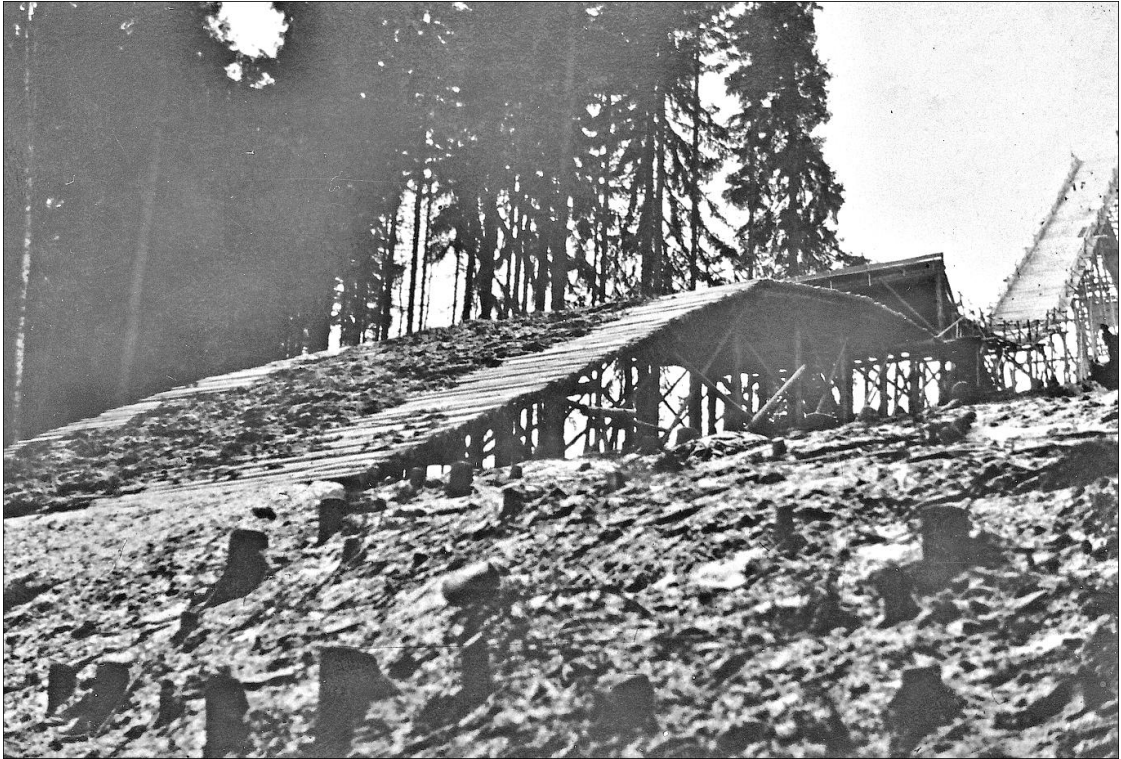
Rekonstrukce horní části bubnu. Původní buben byl ze dřeva, které později nahradil násyp ze zeminy.
