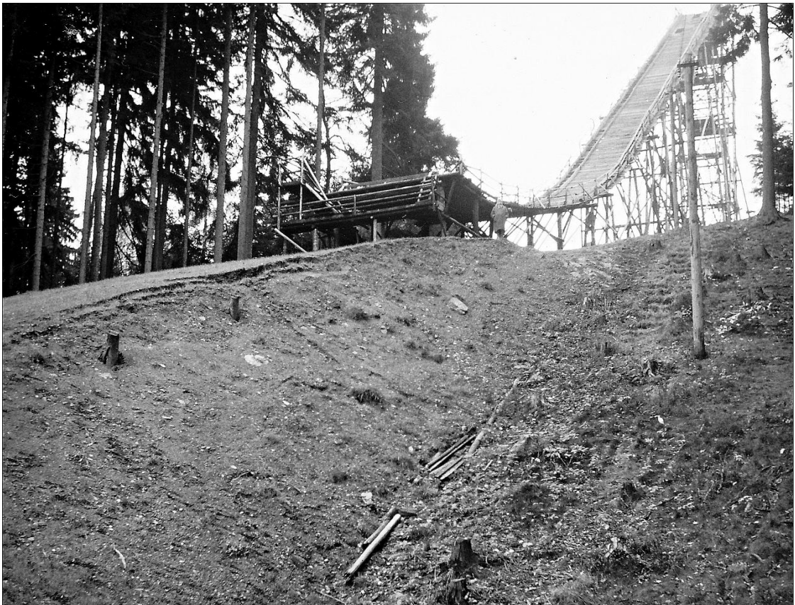
Rekonstrukce horní části bubnu. Původní buben byl ze dřeva, které později nahradil násyp ze zeminy.
