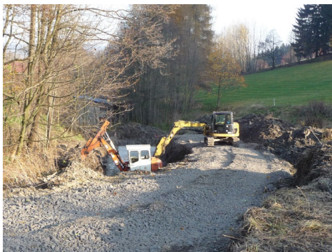
Příprava betonování opěrné zdi ve Trčiči
