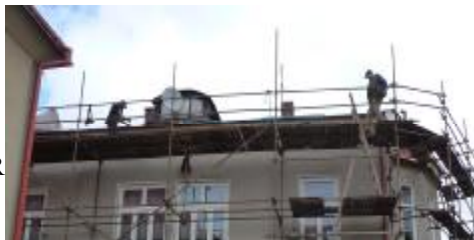
Oprava střechy na domě č. 8 probíhá
